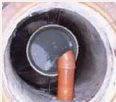
... Befüllung mit Fäkalwässer (Zulaufrohr im Schacht verlängert)
