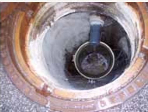
... Befüllung mit Niederschlagswasser (Zulaufrohr im Schacht verlängert)
