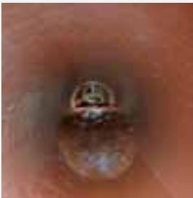
... Wasserwalze nach 20 m Spüllänge, nach Bewältigung zweier Kuppen und der ansonst nur mit 0,7 ‰ Gefälle verlegten Rohrleitung
